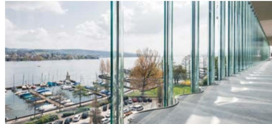
Für die 6.475 m<sup>2</sup> große, vorgesetzte "Wellglasfassade" von Swiss Re Next, wurden über 900 senkrecht angeordnete Glaswellen angefertigt. Diese wurden mit speziellen Edelstahl-Halterungen versehen und mit Zugstäben vom Gebäude abgehängt.
